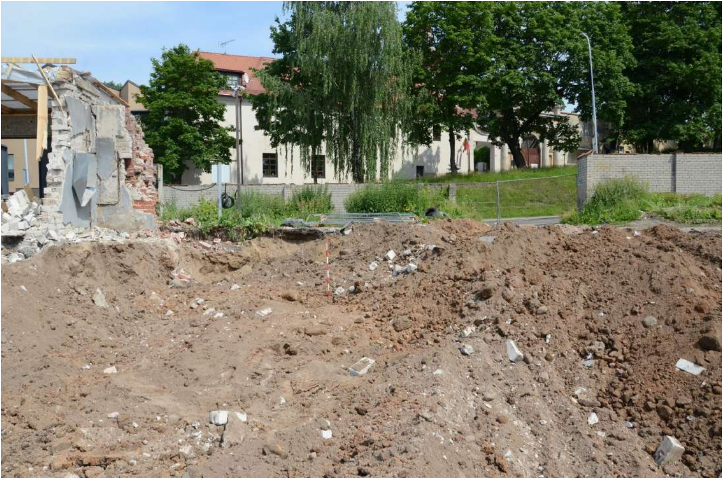
3. Žvalgymai Š, ŠR sklypo dalyje, griauinant garažus ir nuimant asfalto dangą. Vaizdas iš R.
