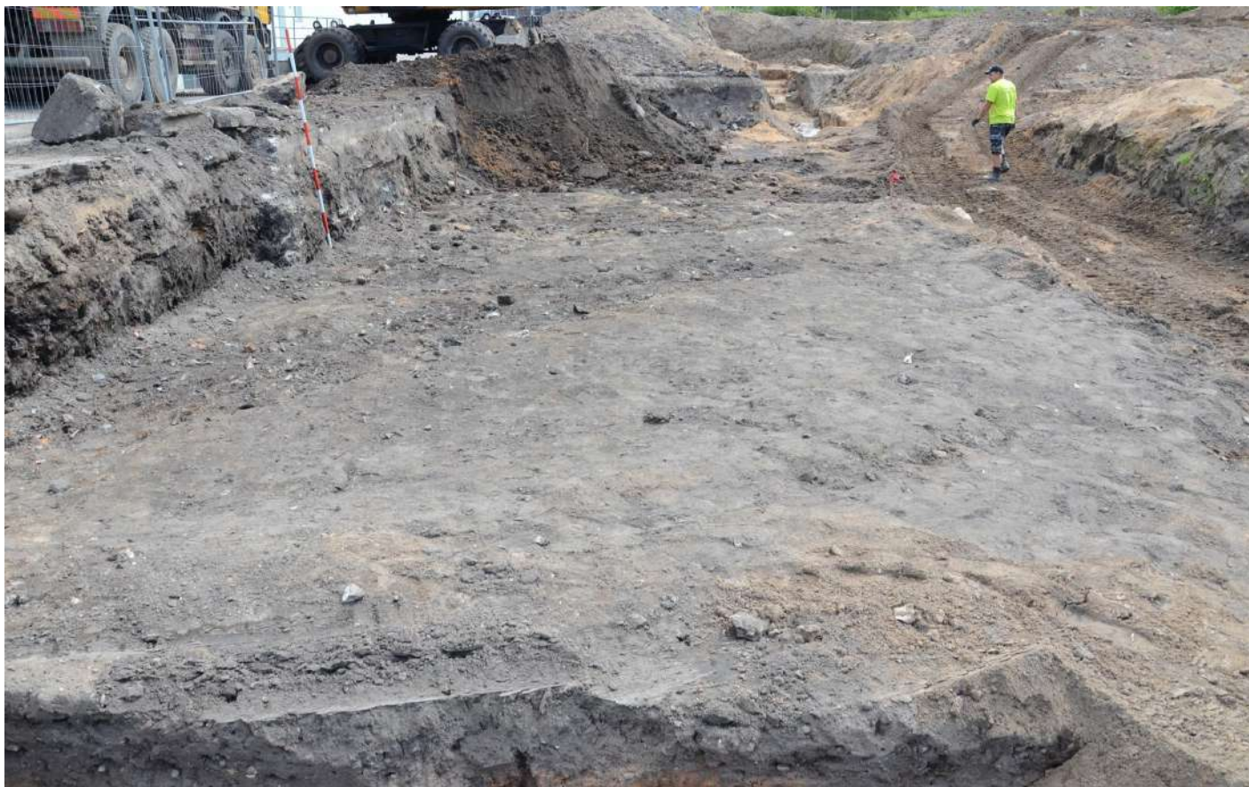
14. Perkastos Nr. 17 vieta nuniveliavus paviršių iki 1,2–1,3 m gylio nuo žemės paviršiaus. Vaizdas iš V.
