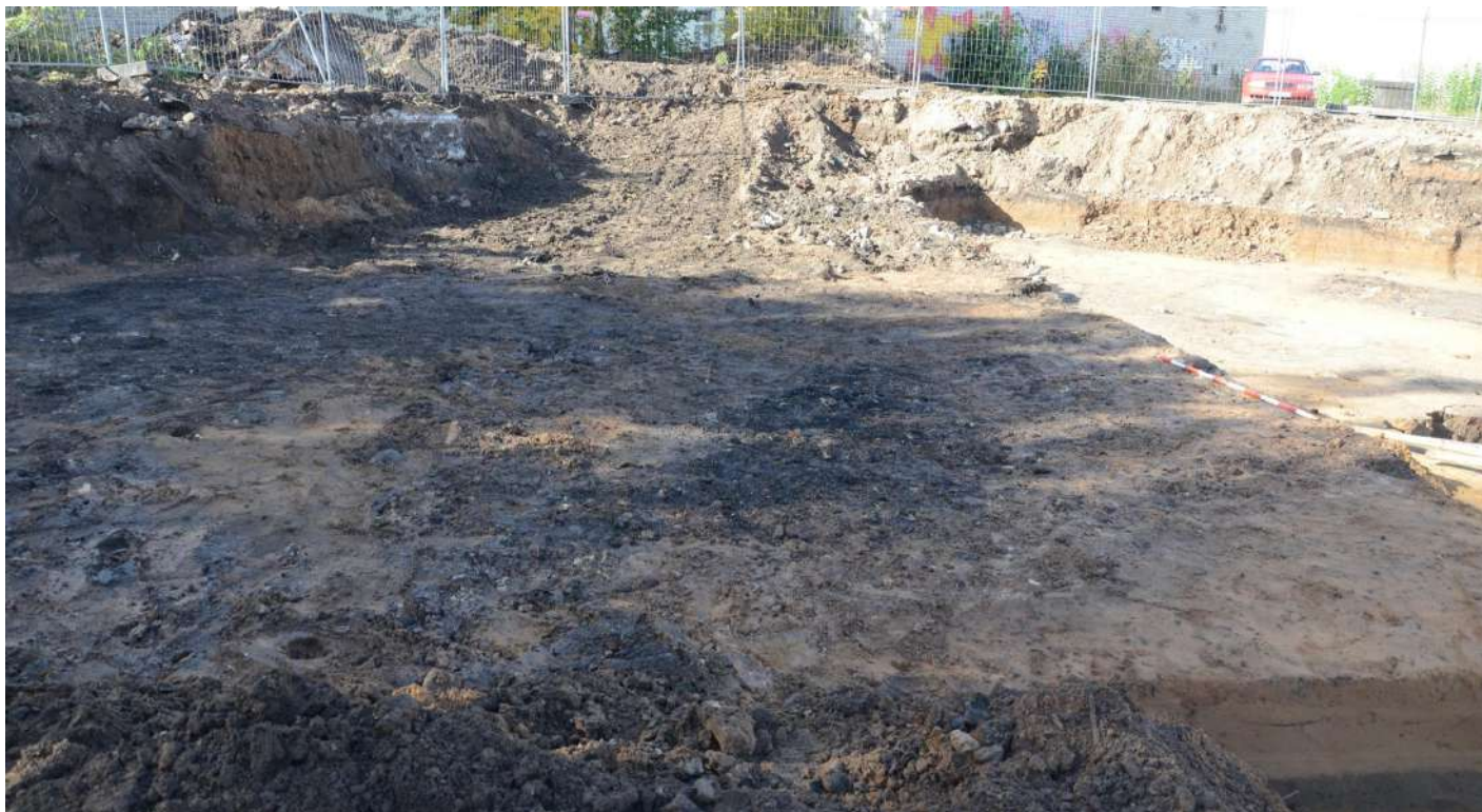
48. Perkamos Nr. 31 vieta nuniveliavus paviršių iki 1,1 m gylio nuo žemės paviršiaus. Vaizdas iš R.
