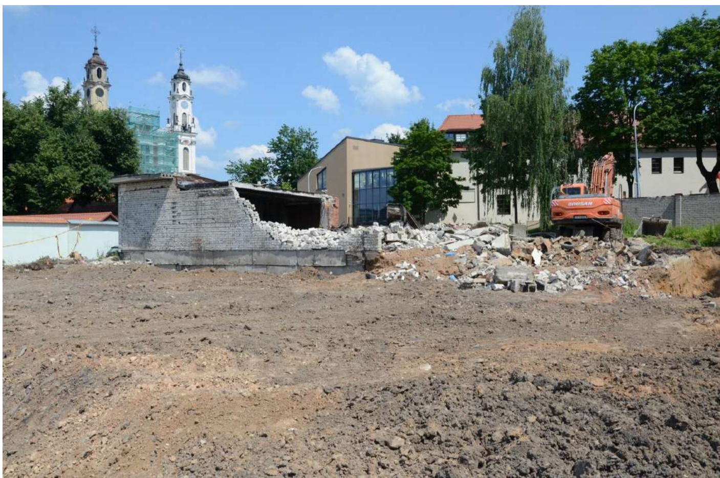
2. Žvalgymai Š, ŠR sklypo dalyje, griauinant garažus ir nuimant asfalto dangą. Vaizdas iš PV.
