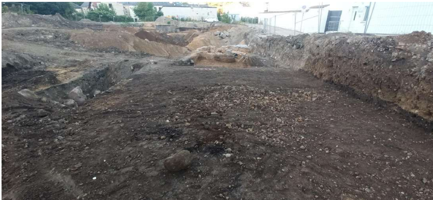
21. Perkamos Nr. 20 vieta nuniveliavus paviršių iki 1,3 m gylio nuo žemės paviršiaus. Vaizdas iš R.
